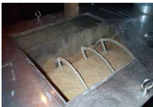
▲ バイオ式(オガクズ)トイレ オガクズの中の微生物がし尿を分解します。
